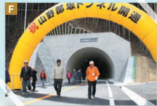
八千代区大屋と加美区山野部を結ぶトンネルが開通しました。安心して往来できる道ができ、生活の利便性が大きく向上しました。
